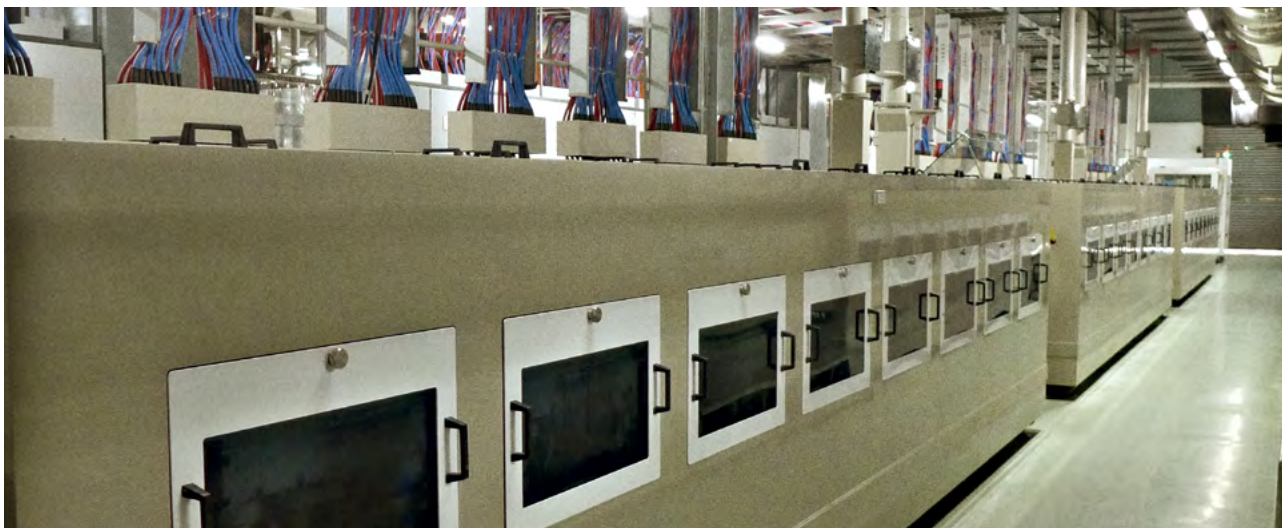
Pozioma linia galwanizująca wykorzystywana do wypełniania miedzią mikroprzełotek w produktach HDI.
